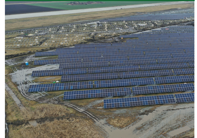
KUNMADARAS FOTOVOLTAIKPARK – 57,6 MWP – DAVON 12,49 MWP VON UNS ERRICHTET
